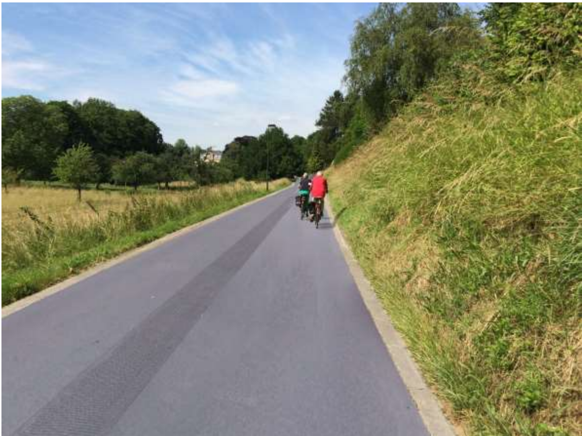
Afbeelding 1. Visualisatie van de fietsstraat met overrijdbare middengeleider met afwijkende vormgeving in streetprint
